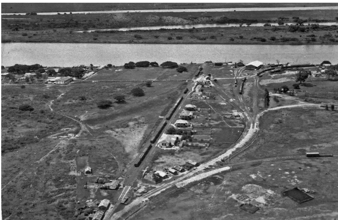
Foto 6 – Porto de Ladário – Ramal Ferroviário da NOB (1960)
