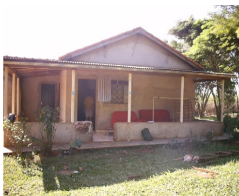
FOTO 12 – Residência atual de Clarice em reforma – Fotografia retirada pela pesquisadora em 20/06/2009 Acervo da pesquisadora
