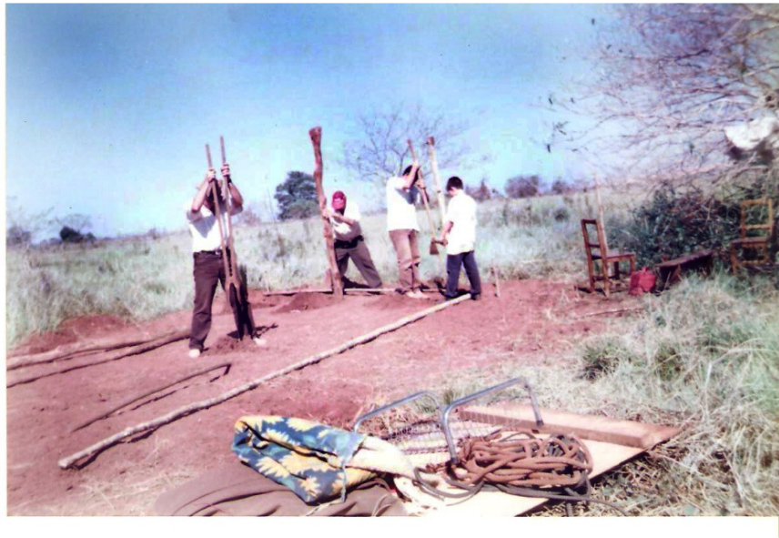
FOTO 10: Construção do barraco de Zoraide e Ademar no Assentamento Sebastião Rosa da Paz em 31/07/2001 – Acervo particular
