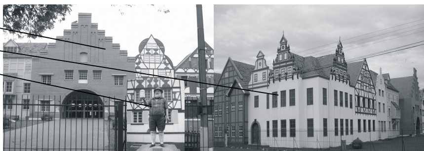
Fig. 07 – Foto montagem. Vista parcial da construção do novo centro de eventos. Assim como o projeto original, cada uma de suas fachadas representam uma região da Alemanha. Ao lado direito do hall de entrada, situa-se um monumento em homenagem ao Opafass . Fonte: arquivo pessoal – 2007.
