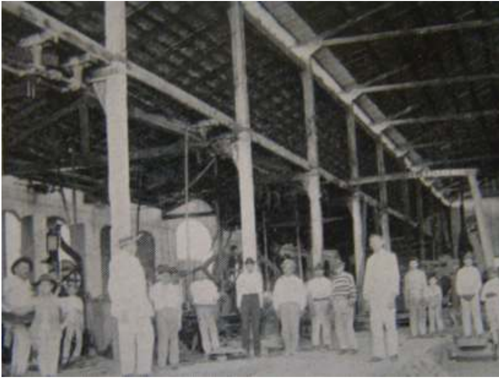
Trabalhadores no interior das Oficinas do Arsenal da Marinha de Ladário. Fonte AYALA, Cardoso; SIMON, F. Álbum Graphico do Estado de Matto Grosso. Corumbá/Hamburgo, 1914, p. 191
