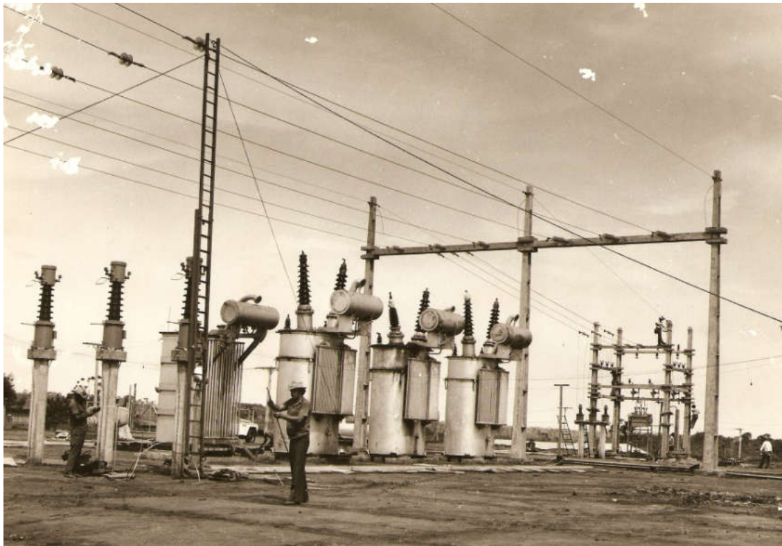
Fotografia 25- Estação de energia Elétrica instalada em 1978
