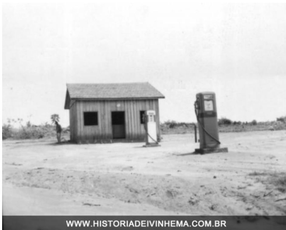
Foto 6. Primeiro posto de gasolina de Ivinhema construído pela SOMECO S/A (1963).
