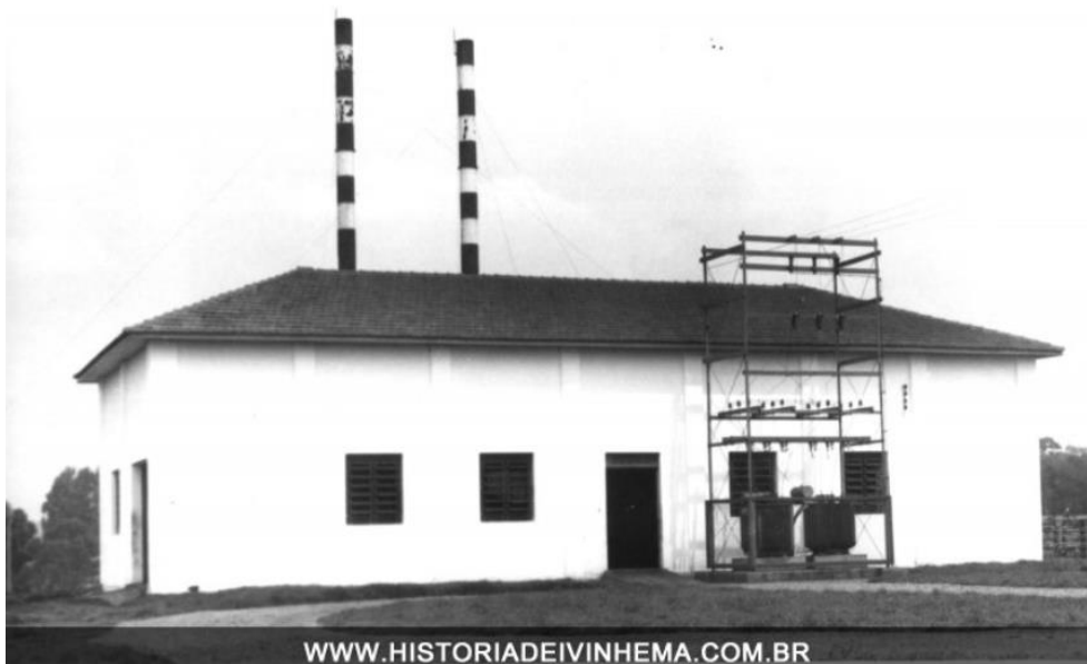
Foto 14. Usina termoeletrica da SOMECO S/A inaugurada em 1973.
