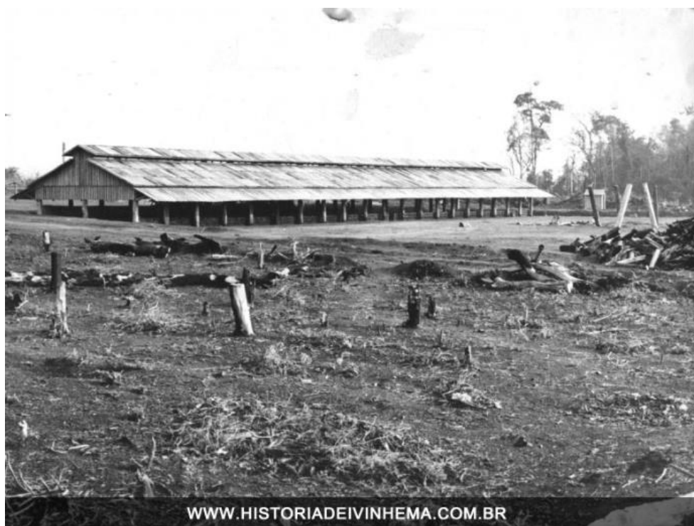
Foto 8. Cerâmica da SOMECO S/A (1965).
