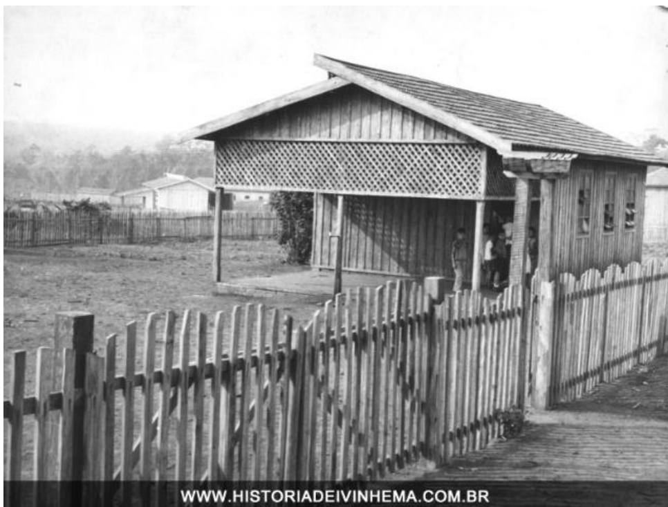
Foto 10. Primeira escola de Ivinhema construída pela SOMECO S/A em 1965.
