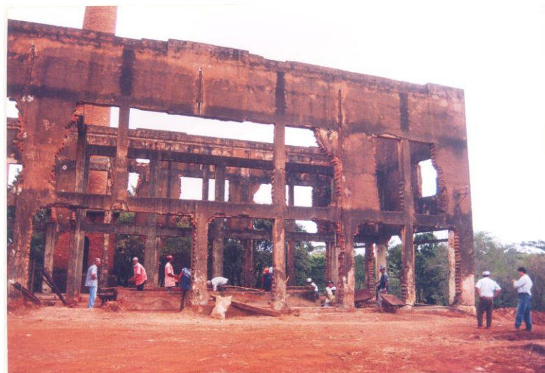
Foto 7 : Limpeza da usina velha (1999)
