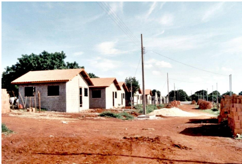
Foto 77: Fase de construção do Bairro Brasil 500, Dourados, 2002.
