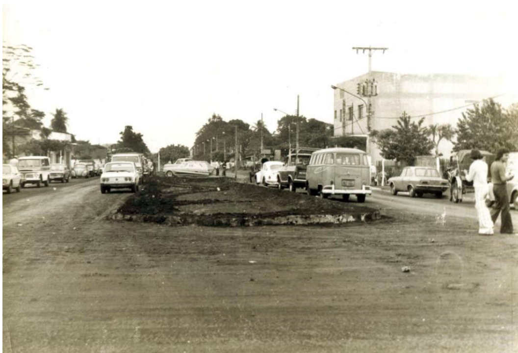
Foto 63: Construção de estacionamento na Rua João Rosa Góes
