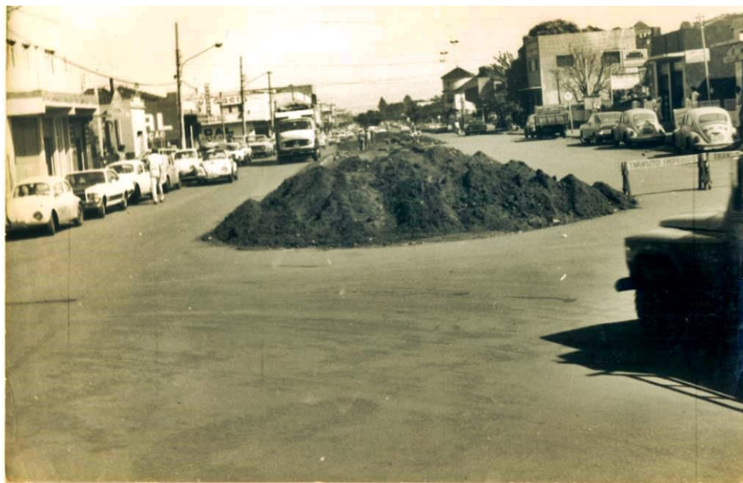
Foto 64: Construção de estacionamento na Avenida Joaquim Teixeira Alves
