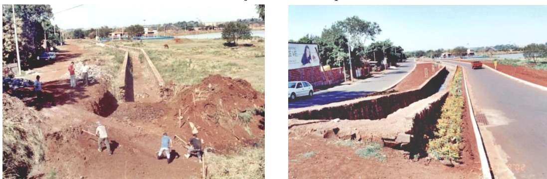
Foto 83: Obra de canalização da Rua Joaquim Távora em 2002.
