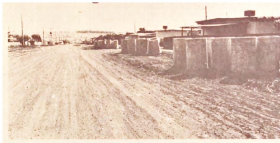
Foto 12: Obras de drenagem em 1979 no BNH 3º Plano
