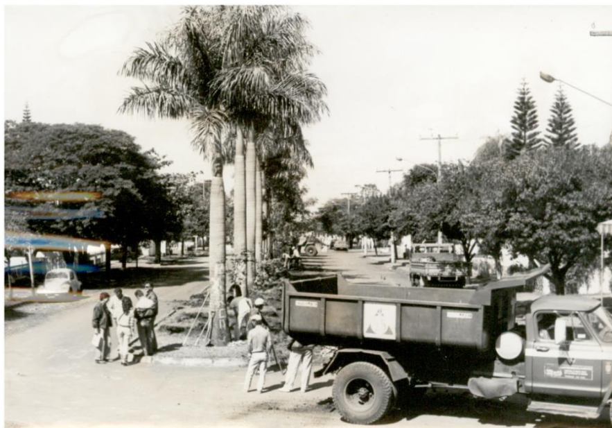
Foto 48: Construção do calçadão da Rua Nelson de Araújo
