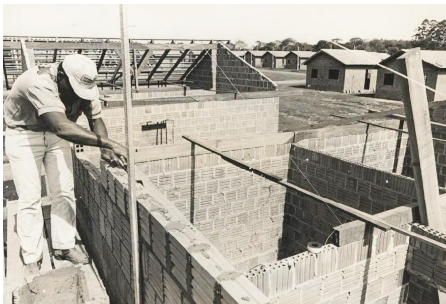
Foto 32: Construção das casas do bairro Canaã 1
