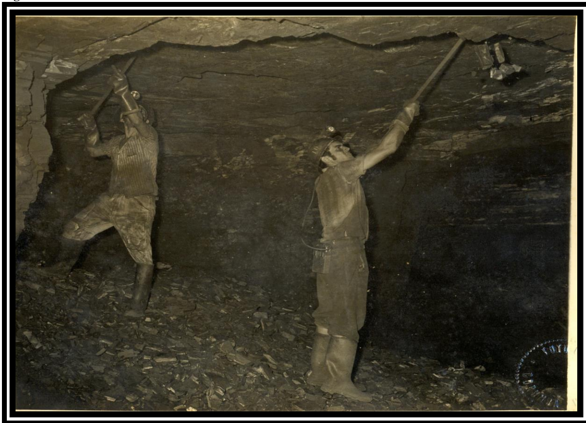
Operários retiram com alavancas minério do teto de umas das galerias da mina.
