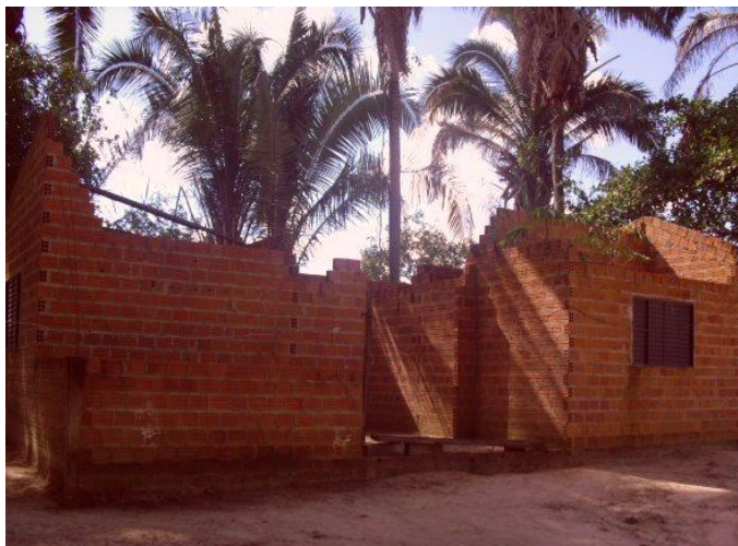
Figura 19 – Obra inacabada do posto de saúde da aldeia Lankraré
